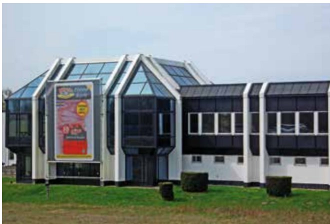
Pågående fasadrengröning – man kan se stor skillnad mellan den rengjorda delen till höger och den ännu obehandlade fasaden till vänster.
