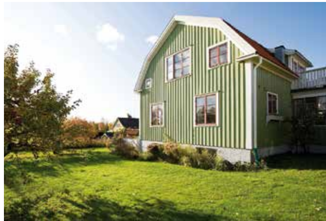
Avslutat projekt. Fasaden har återfått sina ljusa, fräscha färger.
